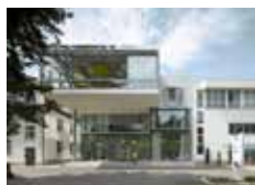
Budynek biurowy Glatten, DE Nr ref. 1277* Zdjęcie: Roland Halbe
